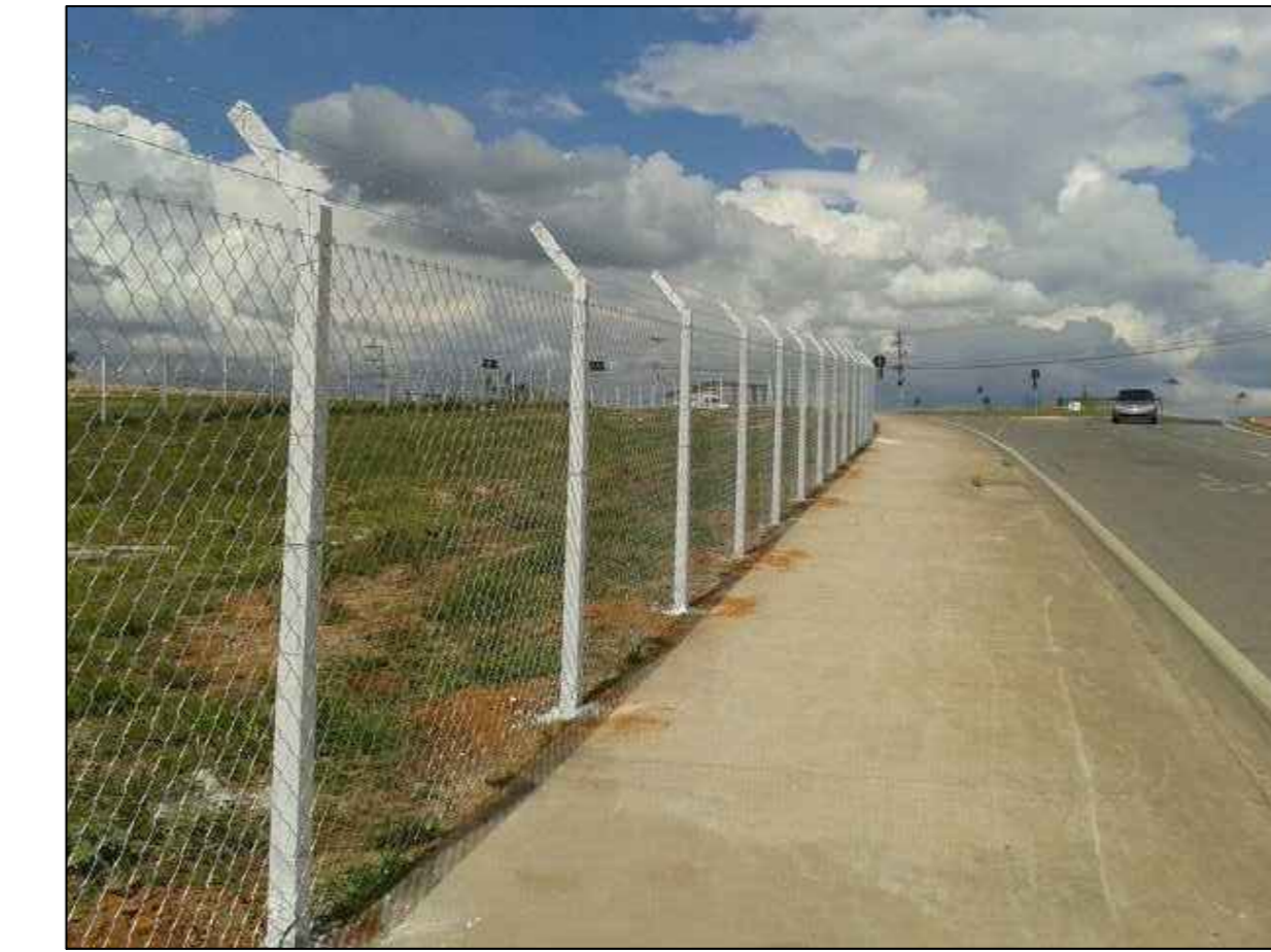
IMAGEM DO MODELO DE ALAMBRADO A SER EXECUTADO, COM TELA DE AÇO GALVANIZADO DE 2', MONTANTES EM MOURÕES DE CONCRETO COM PONTA INCLINADA.
