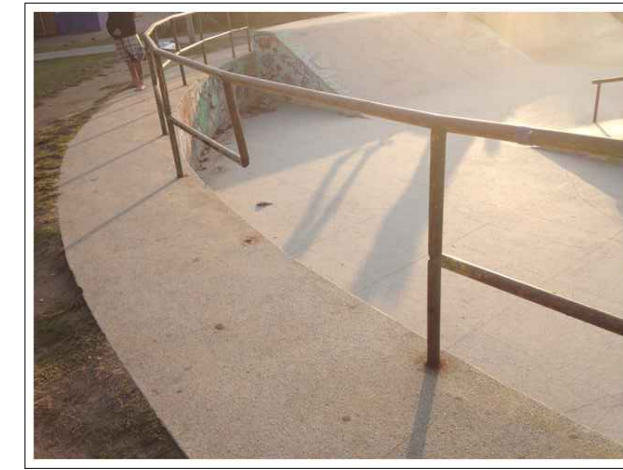
IMAGEM DO MODELO DO GUARDA CORPO A SER EXECUTADO, H = 1,00m EM TUBO GALVANIZADO
